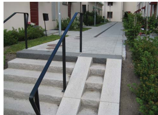
Granittrappa, handledare i svart smide, barnvagnsramp, översta steget i avvikande färg för bättre tillgänglighet.
