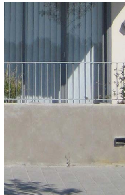
Gräns mellan trottoar och privat mark markeras här genom höjdskillnad., Alternativ till staket kan vara klippt häck. (Lomma)
