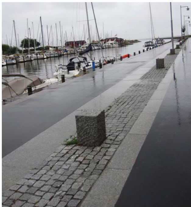
Kaj och körbana skiljs åt av en zon med granithällar, gatsten och granitpollare. Det är lätt att nå kajen med bil. (Lomma)
