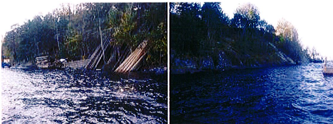
Delområde 6 – Lokalt naturvärde – Hällen går ner i vattnet till cirka 0,2 meters djup. Längs berget låg uppstaplade brädor och annat byggmaterial och i vattnet låg två större flytbryggor
