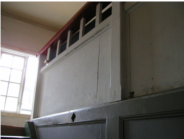
mötet mellan trapploppens bröstning och balkongernas räcken i trappan till den östra balkongen
