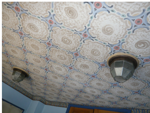
Foajéns tak med ursprungligt dekormåleri och ursprungliga armaturer
