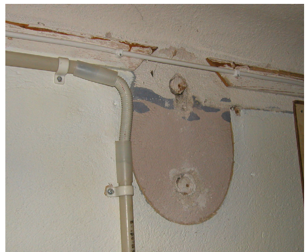
Ursprungligt dekormåleri bakom armatur på balkong
