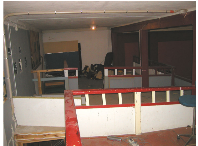
Balkongerna från nordväst
