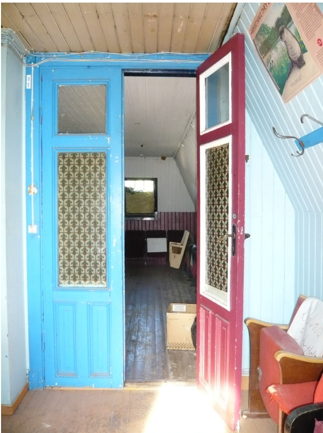
Dörr till kök från tamburdel i bostadsvåningen
