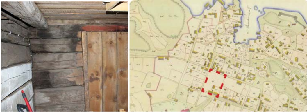
Figur 23 - Gårdsbyggnadernas timmerstomme till vänster och karta som visar att gårdsbyggnaderna haft olika placeringar på tomten under årens lopp.
