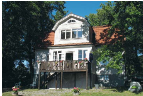
Överby 2:36. Huvudbyggnad samt före detta hönshus uppförda 1923. Ursprunglig byggnadsvolym med frontespis och glasad veranda åt söder samt mindre takkupa och öppen entréveranda åt norr.
