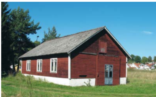
Överby 2:72. Båtskjul/verkstad uppförd 1954.
