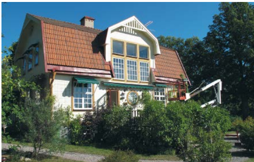
Överby 2:20. Uppförd 1909. Ursprunglig byggnadsvolym med frontespis åt söder samt mindre takkupa åt norr.
