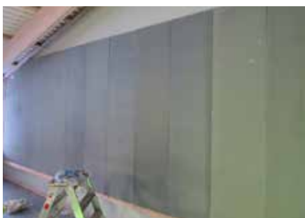
Konstverket fick ett regelverk på baksidan och på framsidan sattes styva skivor inför nedmontering
