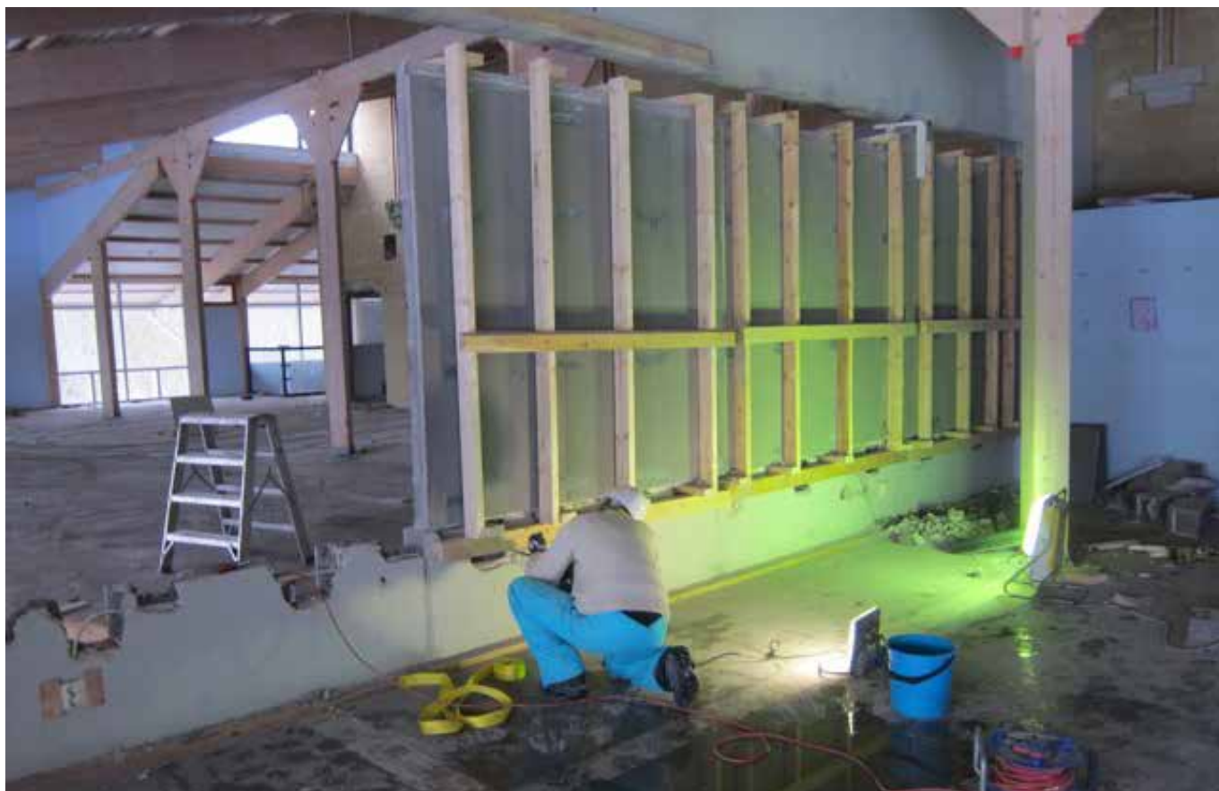
Ett regelverk, byggt på plats, har satts fast på baksidan av målningen. Första biten har här tagits bort från väggen i gamla militärmatsalen på Rindö.
