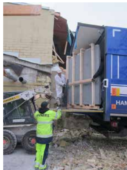
Nedmonteringen gick bra och konstverket kunde transporteras till en lagom tempererad förvaringsplats.
