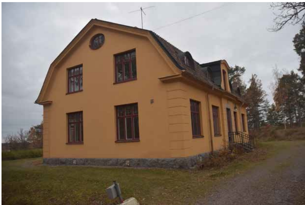
Figur 9 - Villans östra fasad. Detta var den fasad man mötte när man kom från regementet. Fasaden är sparsmakat elegant med treluftsfönster i både bottenvåning och vind.
