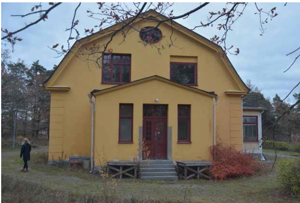
Figur 10 - Villans västra gavel med köksentrén i en utbyggnad. Notera att även köksentrén fick kalkstensomfattningar i den nedre delen, ett elegant sätt att hindra att putsen skadades vid dörren.
