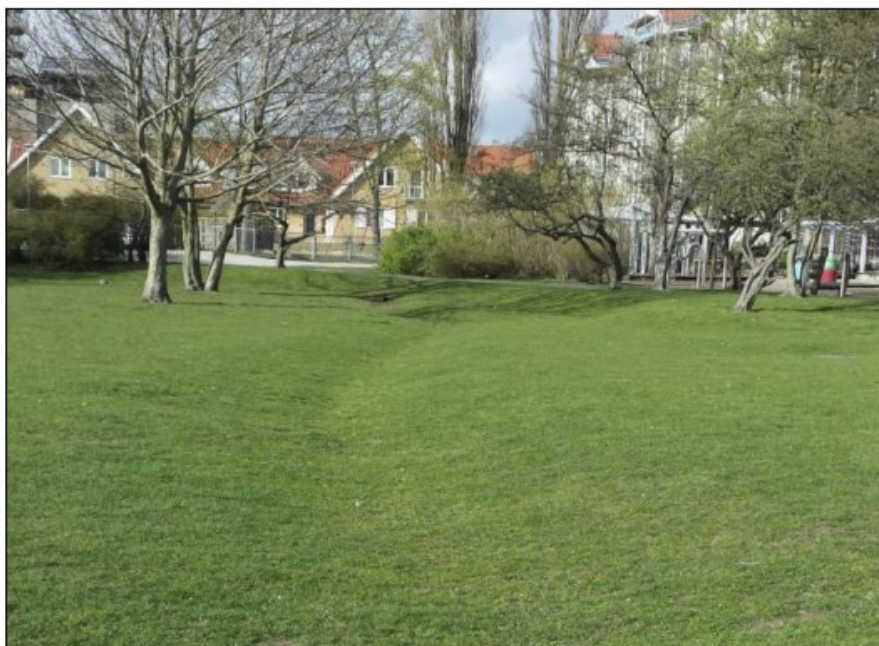
Figur 30 - Exempel på skålformad avledningsyta som föreslås anläggas.
