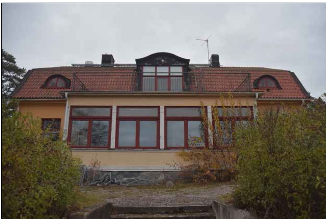
Figur 11 - Villans sydfasad med verandan omgiven av två tvålufts-fönster. Fönsterstorlekarna anpassades alltså till väderstrecken. Verandans fönster är sekundära och förenklade, pelarna på verandan är dock huvudsakligen original.
