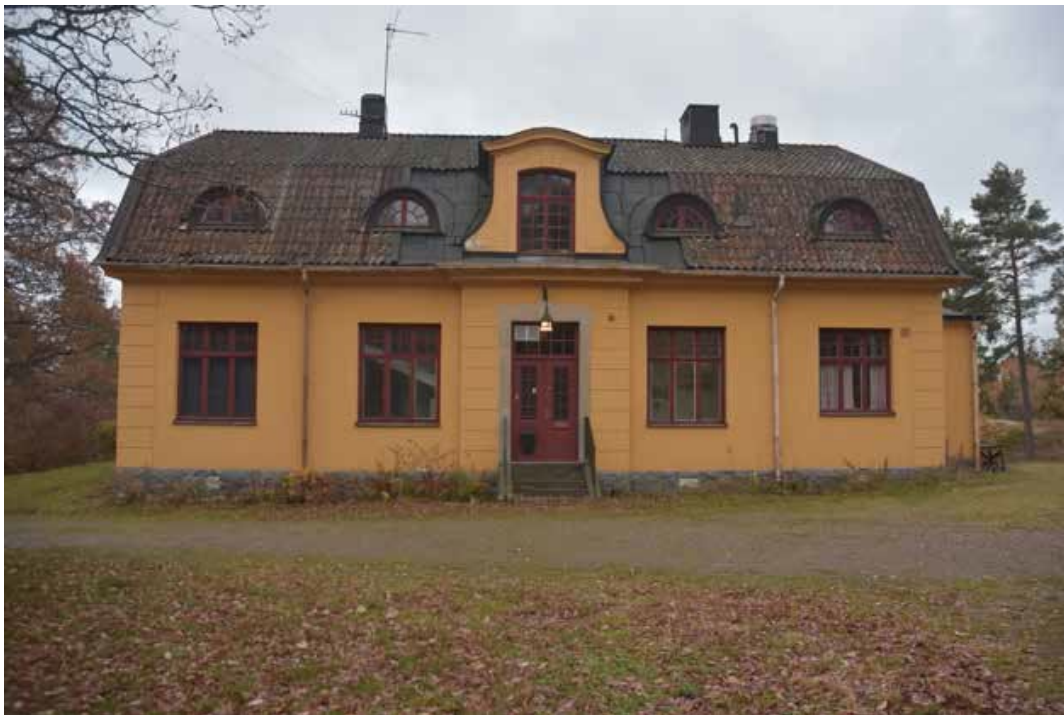
Figur 8 - Byggnadens nordfasad med grund av granit, putsade fasader med rusticerade hörnkedjor och i mittenentrén med kalkstensportal omgiven av en diskret bandrusticerad risalit. Över entrén en takkupa med putsad dekorgavel med
