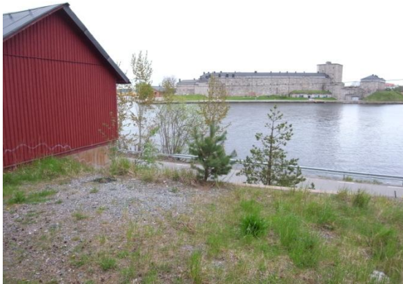
Nätcontainerplats. Fundament anlagd på 1980-talet
