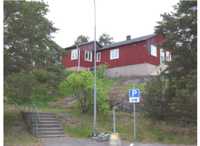
Ursprungligen bostadsbyggnad tillbyggd trol. 1940-tal "radion" (militär). Nuv. vandrarhem
