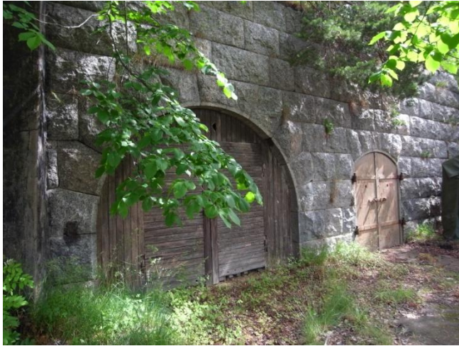
22a batteriets ammunitionsförråd med ursprungliga portar
