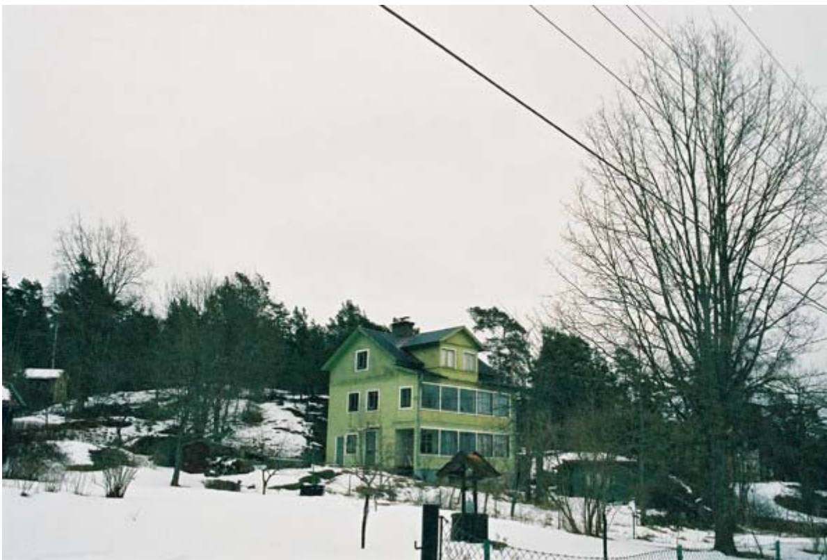
7 Rindö 2:168, fr NV. Två villor som ingått i Rindöbadens anläggning, troligtvis som familjehotell; nu privatägda.
