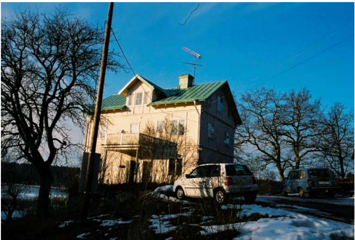
Rindö 3:238, fr S. Bostadshus, byggt som sommarvilla på tidigt 1900-tal.
