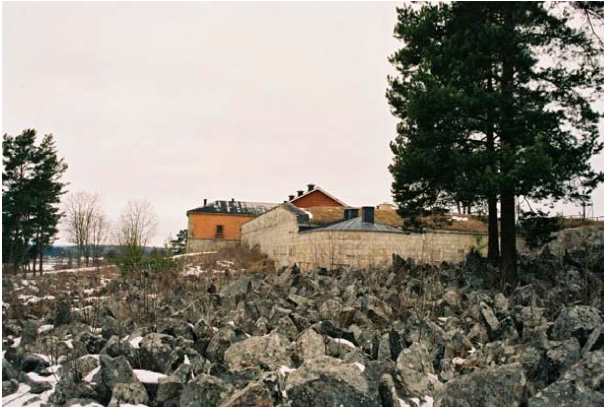
2 Rindö 2:263, Redutten fr S, i förgrunden de upprättstående vassa klippblocken som placerades där för att göra anläggningen svåråtkomlig.
