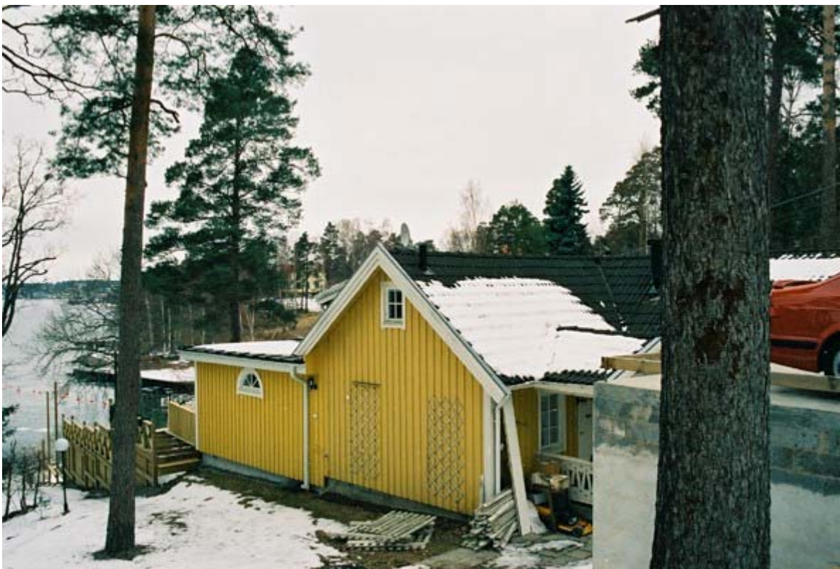
8 Rindö 2:49, förtätning genom avstyckad mark kring uthus, fr SÖ.
