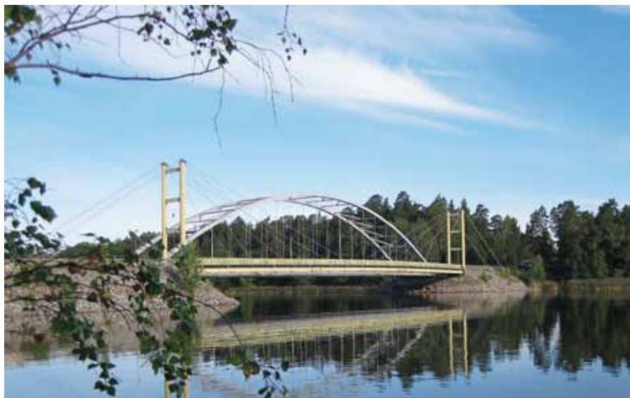
Länsväg 274 passerar Vaxholm, sedan med vägfärja till Rindö och över Oxdjupet till Värmdö. Vaxholmsbron sammanbinder Kullön och Vaxön. Parallellt med bron går en gång- och cykelbro som har Sveriges längsta spann byggt i trä.
