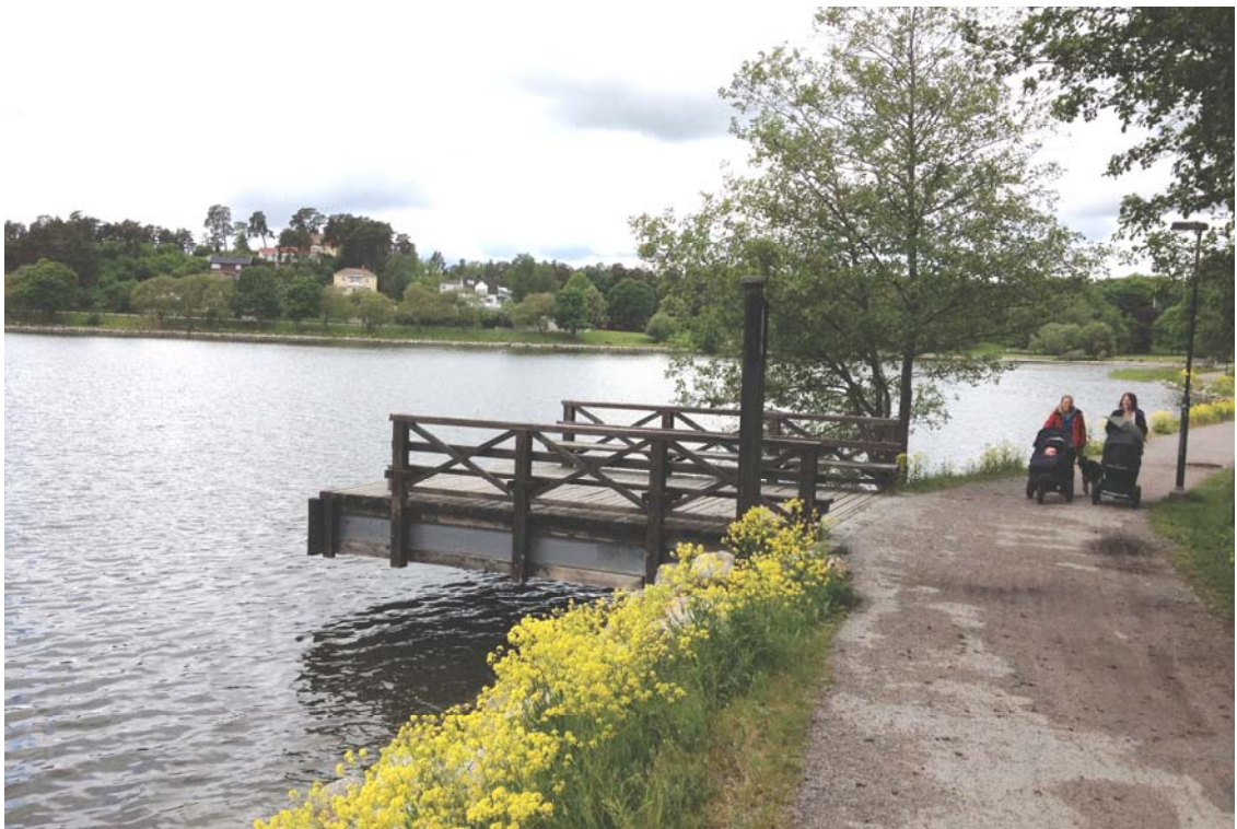
Exempel på brygga med betongfundament på land.
