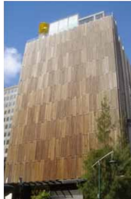
Council House, Melbourne, Australia, DesignInc Hållbart hus med fasad av vertikala smala luckor som regleras efter behov
