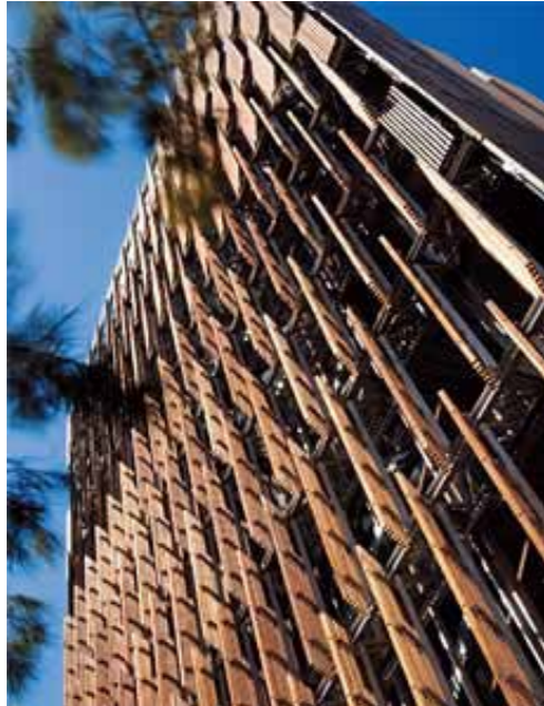
Council House, Melbourne, Australia, DesignInc Hållbart hus med fasad av vertikala smala luckor som regleras efter behov
