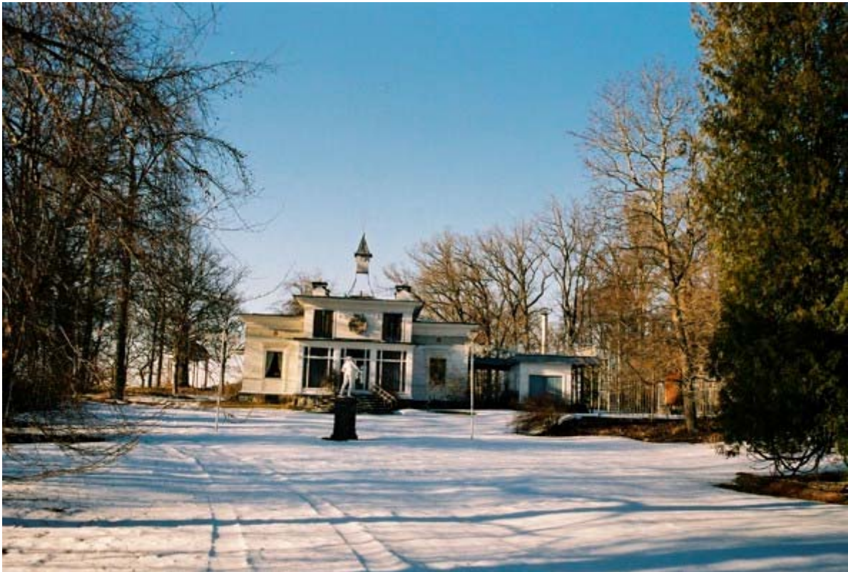
4 Skarpö 1:10, Norrängens huvudbyggnad, fr SÖ.
