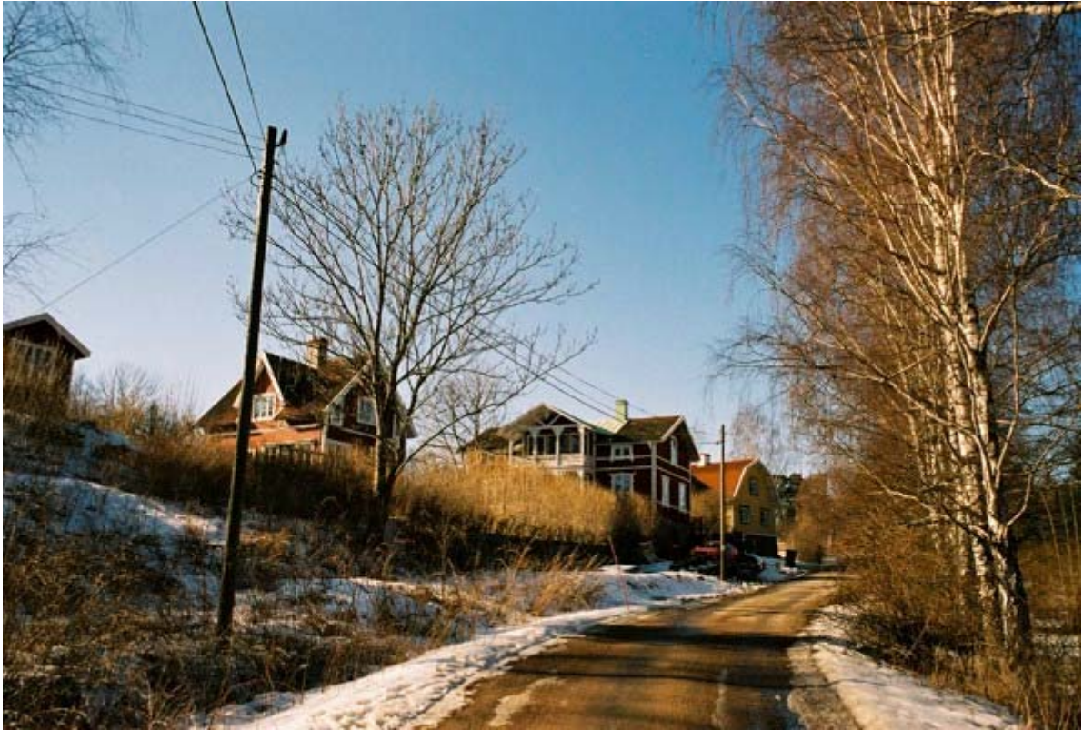
8 Skarpövågen, fr NÖ. Skarpö 1:336, 1:335 & 1:170, gamla hus vid Östergården.
