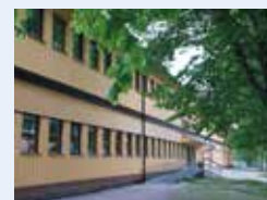
Rindö skola (huvudbyggnaden) Rindövägen 82
