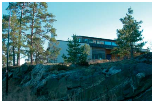
Nybyggd villa, väl inpassad i terrängen i Värmdö
