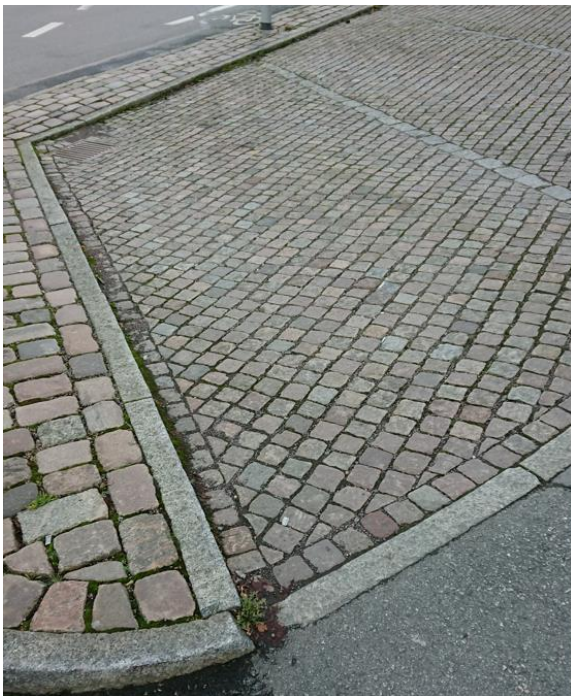
Figur 5.4. Exempel på parkeringsplats med genomsläpplig beläggning. Kan även utföras med hålsten för gräsarmering eller med genomsläpplig asfalt.
