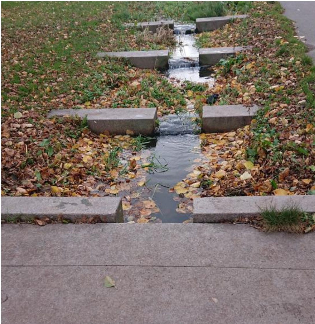
Figur 5.6. Exempel på dike med trappning/strykning av flöde och en bro. (Gicon: Slottsskogen, Göteborg).
