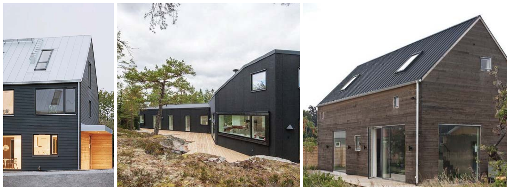
Fasadmaterial som kompositkivor, plåt och trä med inslag av naturmaterial i detaljer, skärmtak och trädäck
