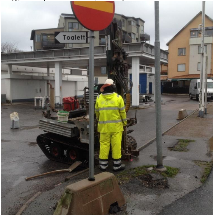
Foto 2: Borrning av BH6. Förorenad jord dokumenterades mellan 0,5-1,1 m u my. Berggrunden påträffades vid 1,1 m u my.
