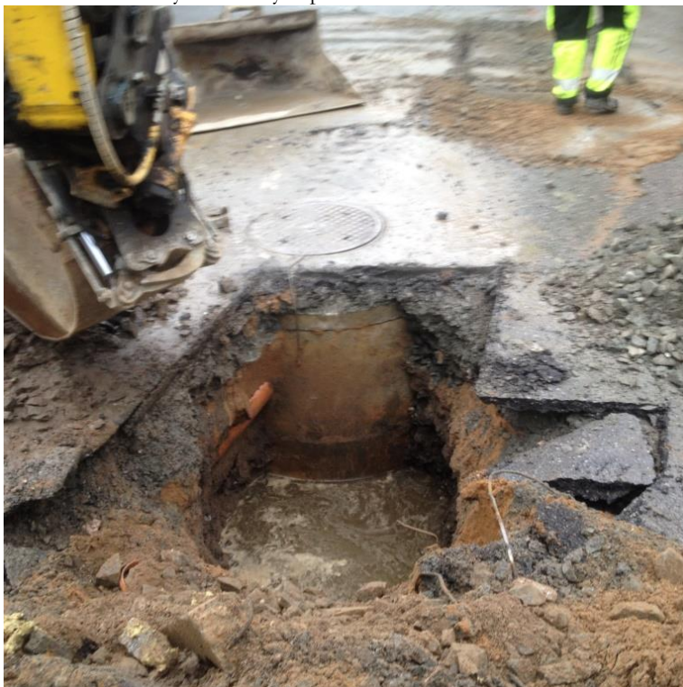
Foto 4: Schaktning av provgrop PG2. Förorenad jord dokumenterades vid 1,3 m u my, strax under vattenytan som syns på bilden.
