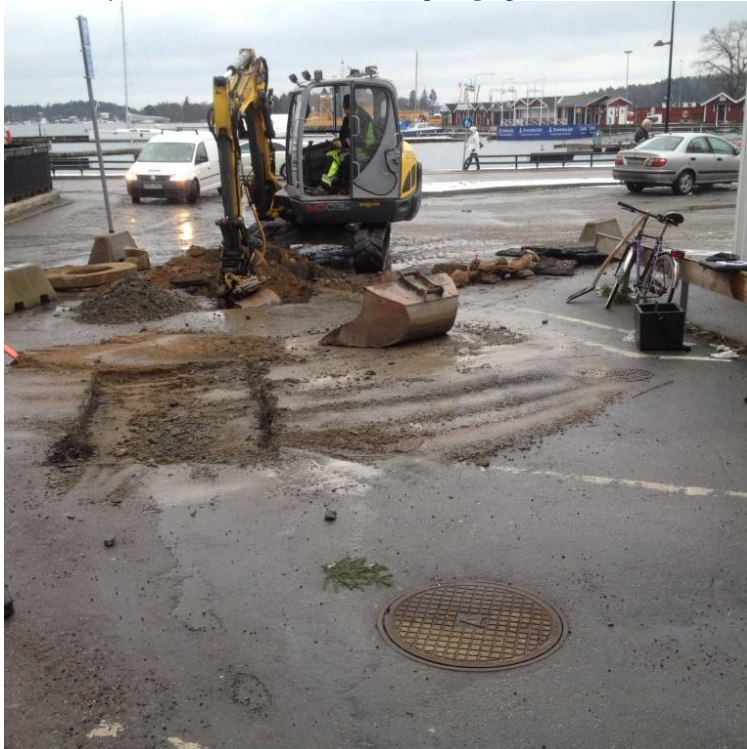
Foto 4: Schaktning av provgrop PG2. Förorenad jord dokumenterades vid 1,3 m u my, strax under vattenytan som syns på bilden.
