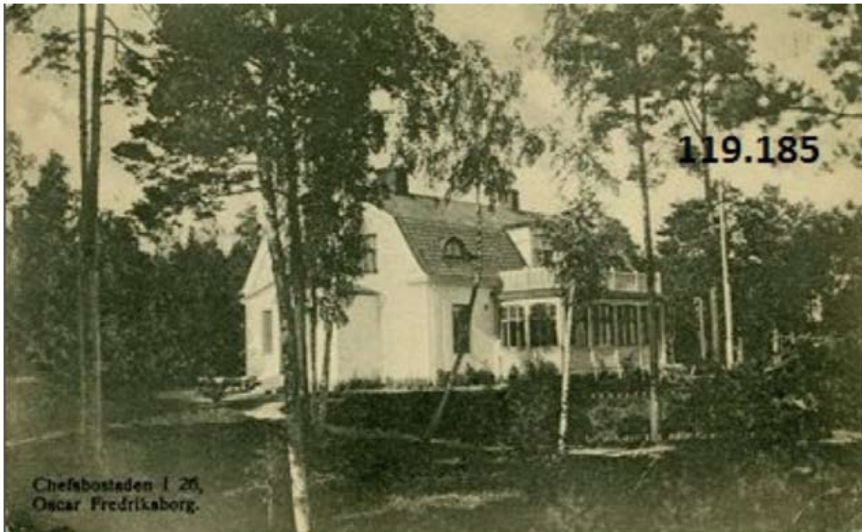
Äldre vykort som visar chefsbostaden vid I26 med ursprunglig verandaglasning med jugendfönster och öppnare växtlighet på terrasserna. Notera fasadernas ljusa kulörer samt de björkar som medvetet har sparats kring villan.
